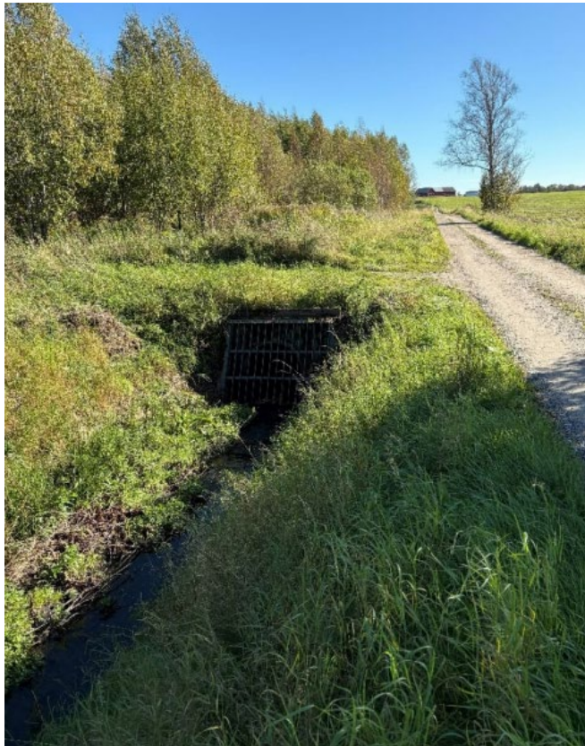
Bilden visar Säbygatan till höger och det öppna diket i planområdets sydvästra kant samt där diket blir kuverterat.
